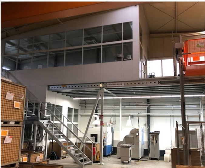
Blick in die Bearbeitung Hinter Stöck Werk 3 in Bisingen mit neuem Montagebereich
